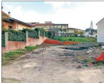
L'area del cantiere
