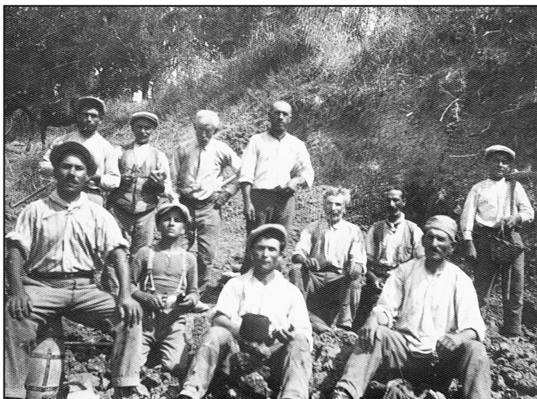
Salemi 1929 - Squadra operai costruttori dello stradale Karbinarusa. Si riconosce il più giovane di tutti, Nicolò Messina del 1913.
