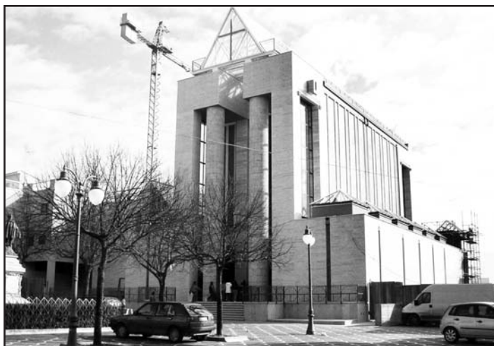
La Chiesa madre; a destra l'interno dell'edificio prima del sisma
