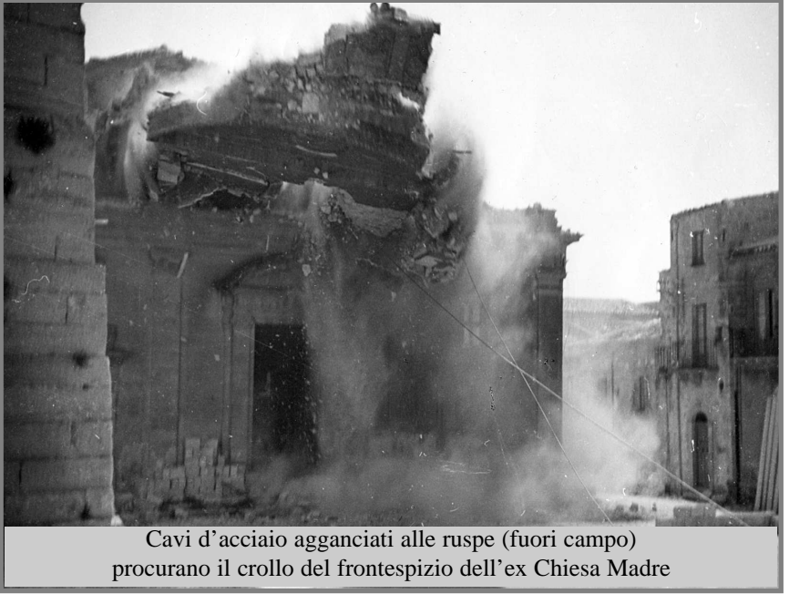
Cavi d'acciaio agganciati alle ruspe (fuori campo) procurano il crollo del frontespizio dell'ex Chiesa Madre
