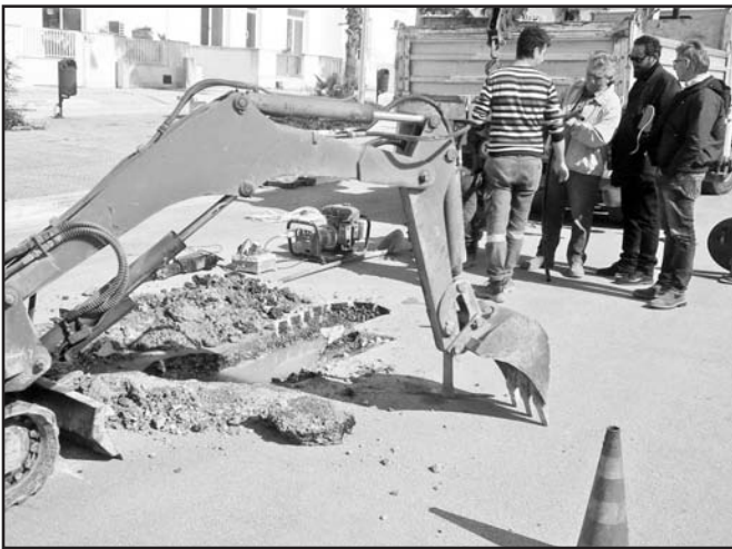
Sopra e a destra due momenti dei lavori sulla rete idrica
