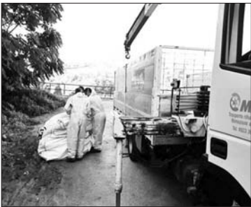
La rimozione dell'amianto
